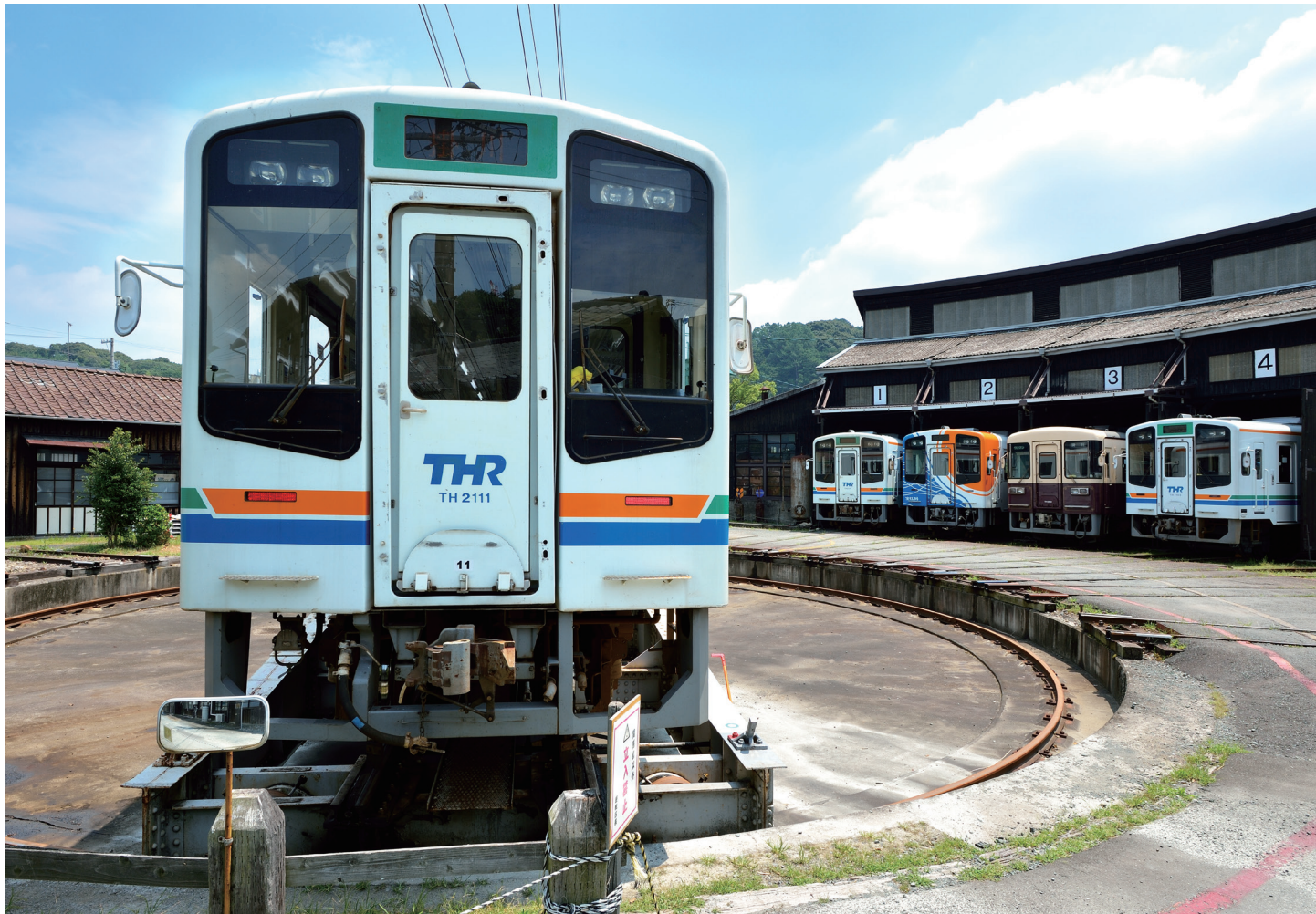
〔機関車転車台〕●天竜浜名湖鉄道 蒸気機関車の進行方向を転換させるために造られたもので、鉄製で直径約18mです。天竜浜名湖鉄道「天竜二俣駅」には可動する転車台が現存しており、国登録有形文化財に登録されています。毎日開催される転車台&鉄道歴史館見学ツアーにて見学可能です。
